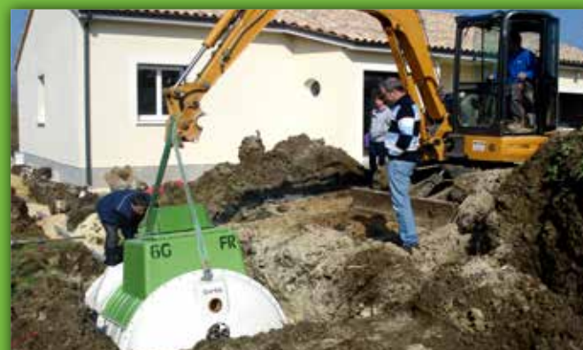
Installation d'une Tricel Novo FR6
