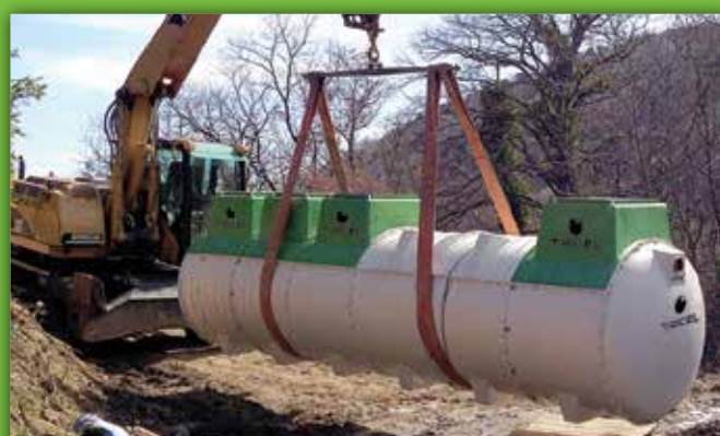
Installation d'une Tricel Novo FR20
